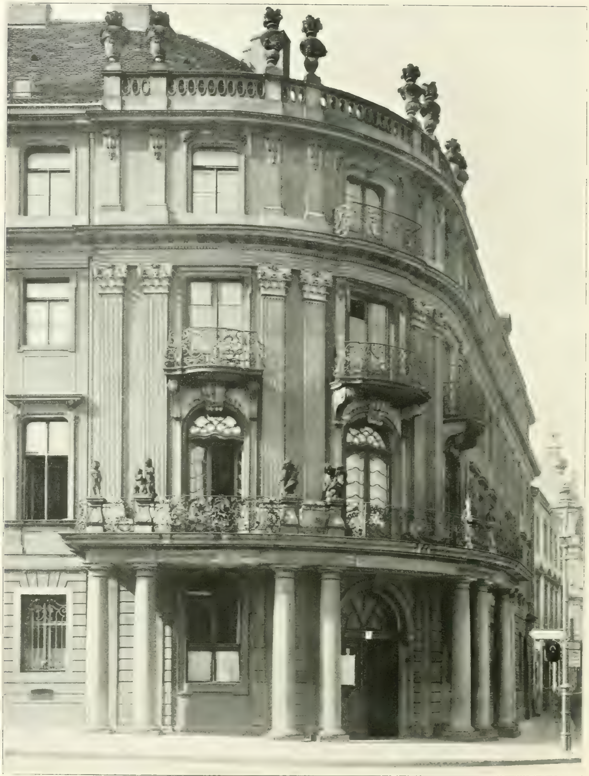
Ephraim's House Poststraße 16 von Dietrichs 1762–65.
